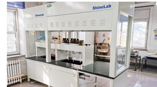
钢研总院中心实验室改进现有通风设施，外接废气净化过滤装置，实验室废气经过滤后排出
